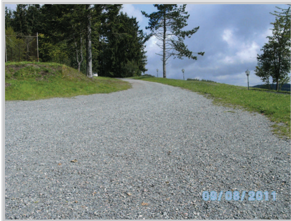
Bild 1 Blick über die aufgeschotterte Fläche östlich des Tennisplatzes von Süden
