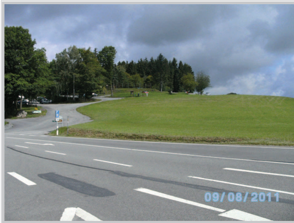
Bild 5 Blick von der Kreuzung der L 3409 mit der L 3120 nach Norden
