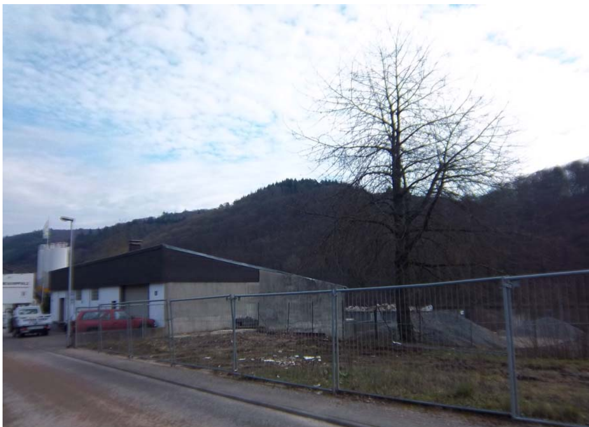
Abbildung 6: Bestandsfoto des Planungsgebiets (Blick entlang der Industriestraße Richtung Nordosten)
