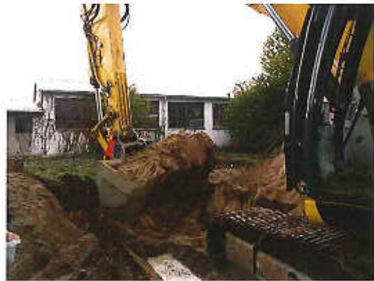
Foto 4 Stich nach Süden, in den Aushubbereich von 2013 (Tank 1). Keine organoleptischen Auffälligkeiten.
