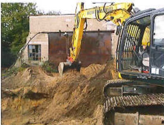
Foto 5 Rückverfüllung Grube nach Haufwerksbeprobung.
