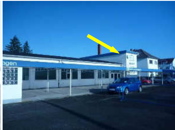
Abb. 8: Weiteres Gebäude mit Flachdach und Blechabdeckung und somit potenziell ebenfalls als Fledermauslebensstätte (7) geeignet
