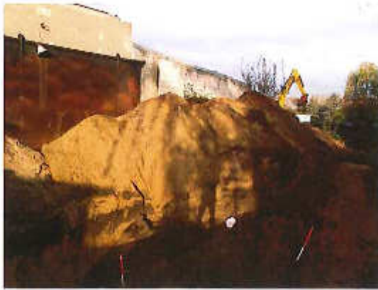
Foto 1 Blick von Südosten auf die ausgehobene Grube des geborgenen Kraftstoff-Erdtanks. Aushub zur Beprobung bereitgestellt.
