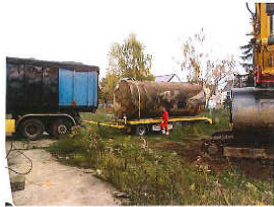
Foto 2 Verladen des geborgenen Erdtanks, geschätztes Fassungsvermögen 20 m³, Abfahren zur Entsorgung.
