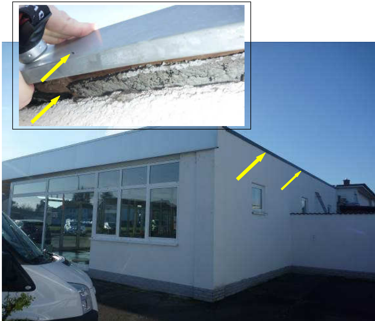
Abb. 6: Lebensstätten (9) von Fledermäusen in Spalten und auf Sims unter Blechabdeckung an einem Gebäude in Flachdachbauweise
