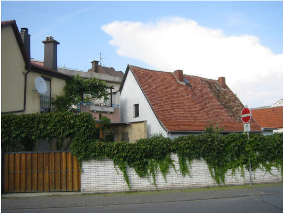
Foto: Gebäude Hgelstrae 2 mit Ansicht der Brandwand und der Dachterrasse des benachbarten Bckereigebudes
