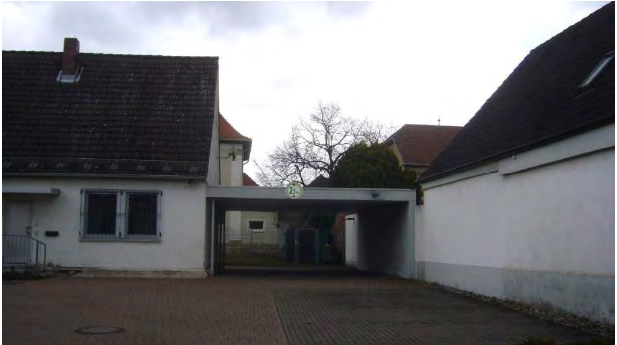
Foto 3 Stellplätze und Nebengebäude von der Backhausstraße aus gesehen
