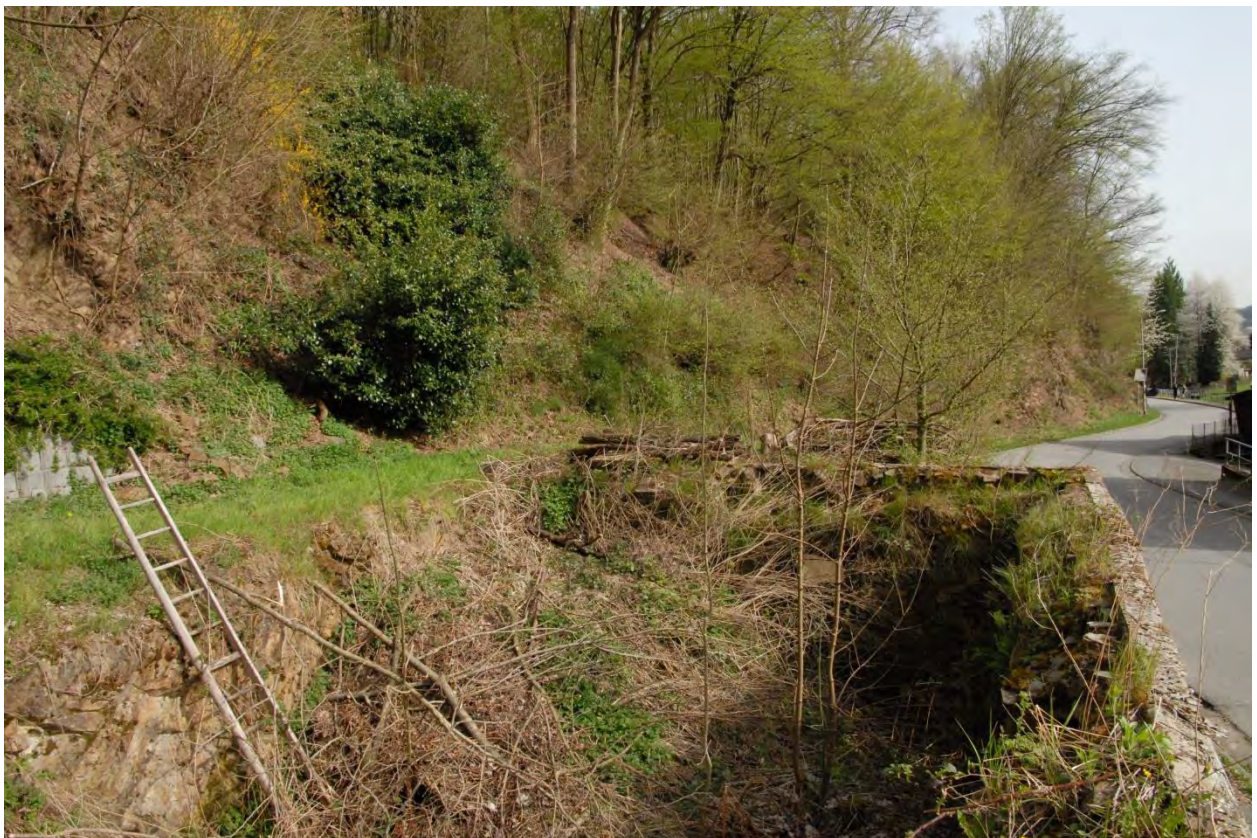
Foto 4 Ehemaliger Keller mit Strauch- und jungem Baumbewuchs
