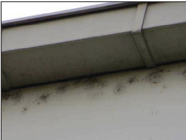
Diese machten deutlich, dass der Abstand zwischen Wand und Regenrinne max. der Dicke des Halterungsbandes entspricht. Die sich hierdurch ergebende, wenige mm breite Spalte ist auch für Zwergfledermäuse zu eng. Dies konnte bei einer zweiten Begehung mit gutem Fernglas bestätigt werden
