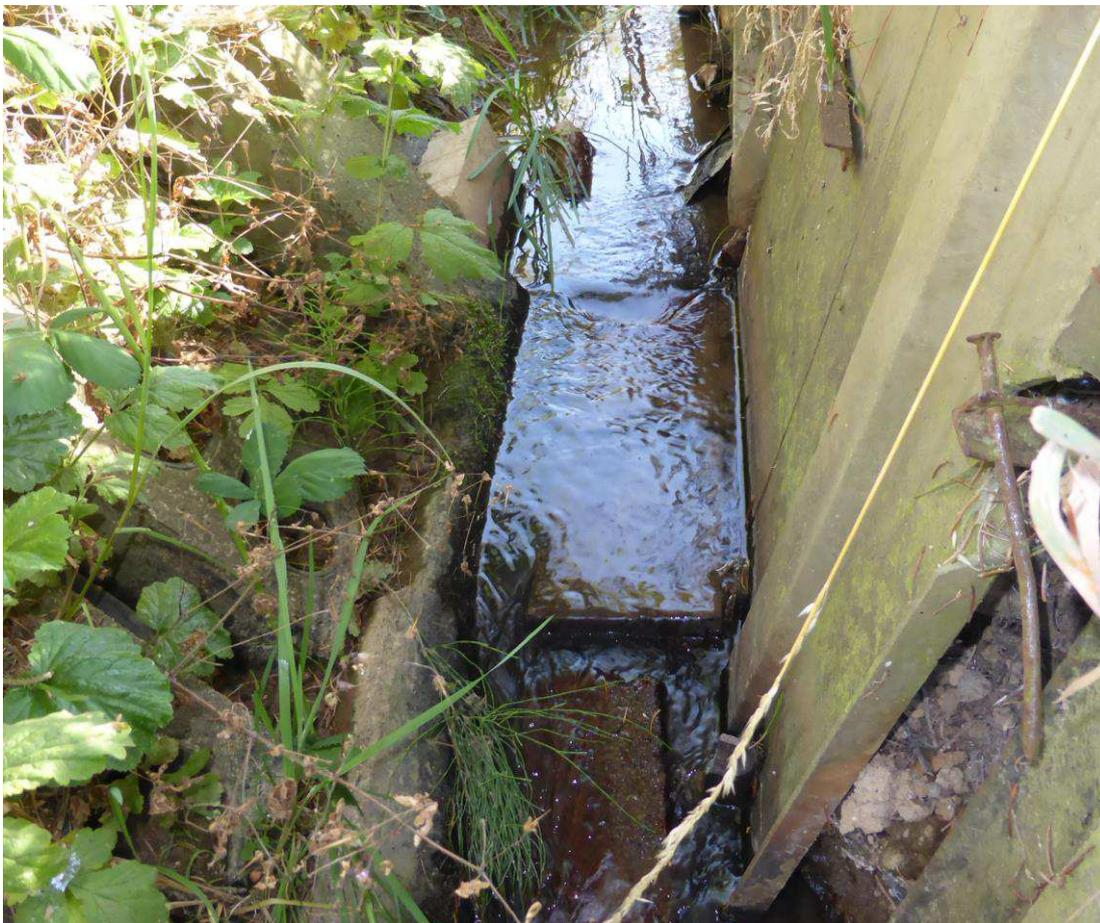
**Abb. 11:** Bachbefestigung mit Betonplatten
