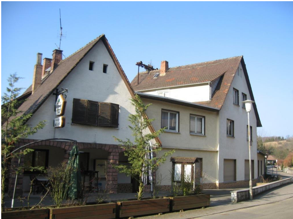
Foto 2: Gebäude „Auf der Au“ Nr. 2
