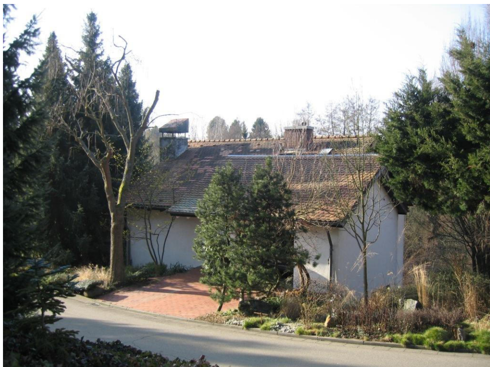
Foto 18: Gebäude „Auf der Au“ Nr. 22
