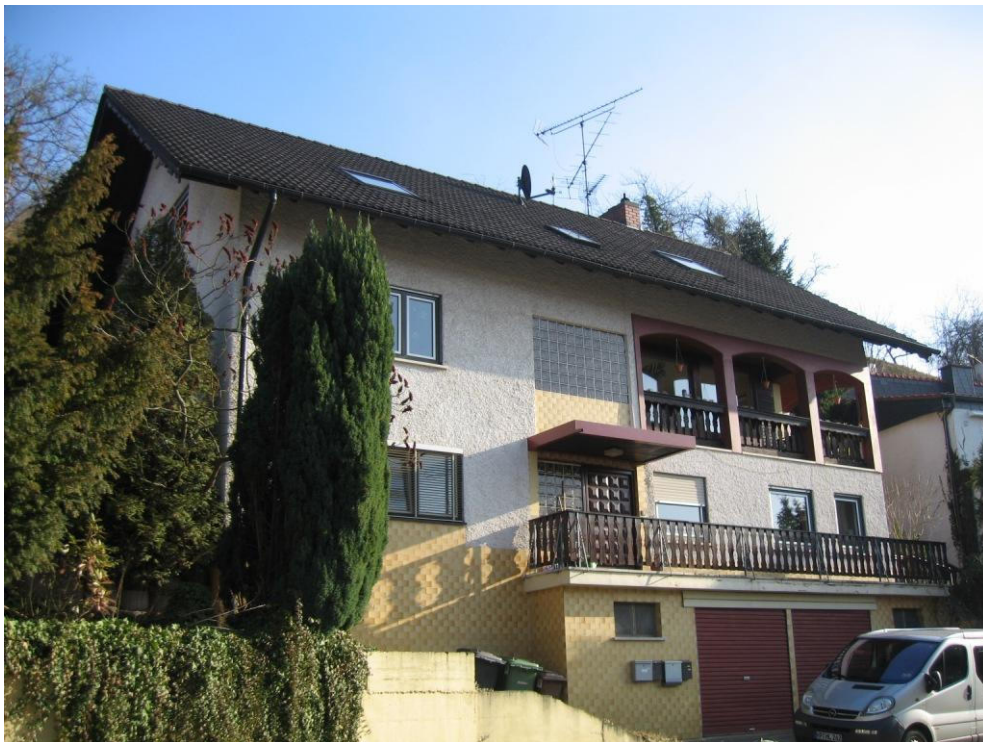
Foto 5: Gebäude „Auf der Au“ Nr. 5
