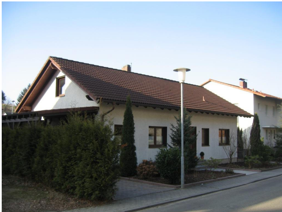
Foto 7: Gebäude „Auf der Au“ Nr. 8
