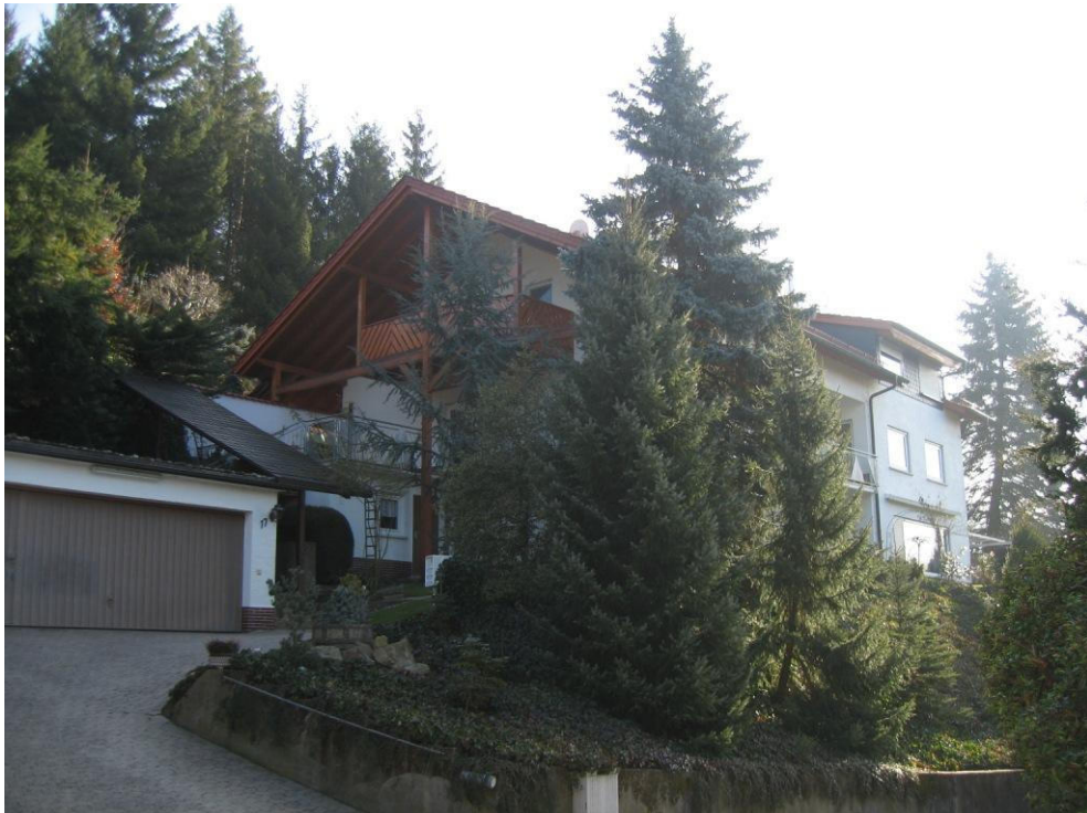
Foto 15: Gebäude „Auf der Au“ Nr. 17
