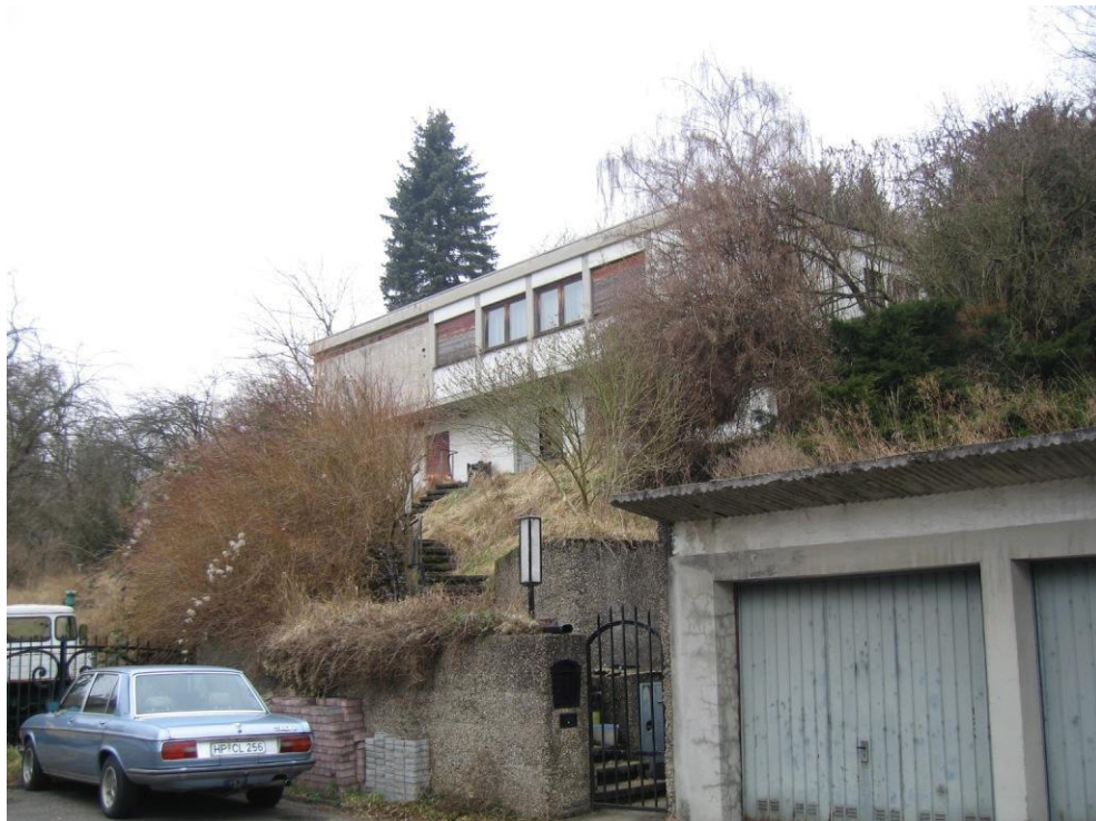
Foto 13: Gebäude „Auf der Au“ Nr. 15
