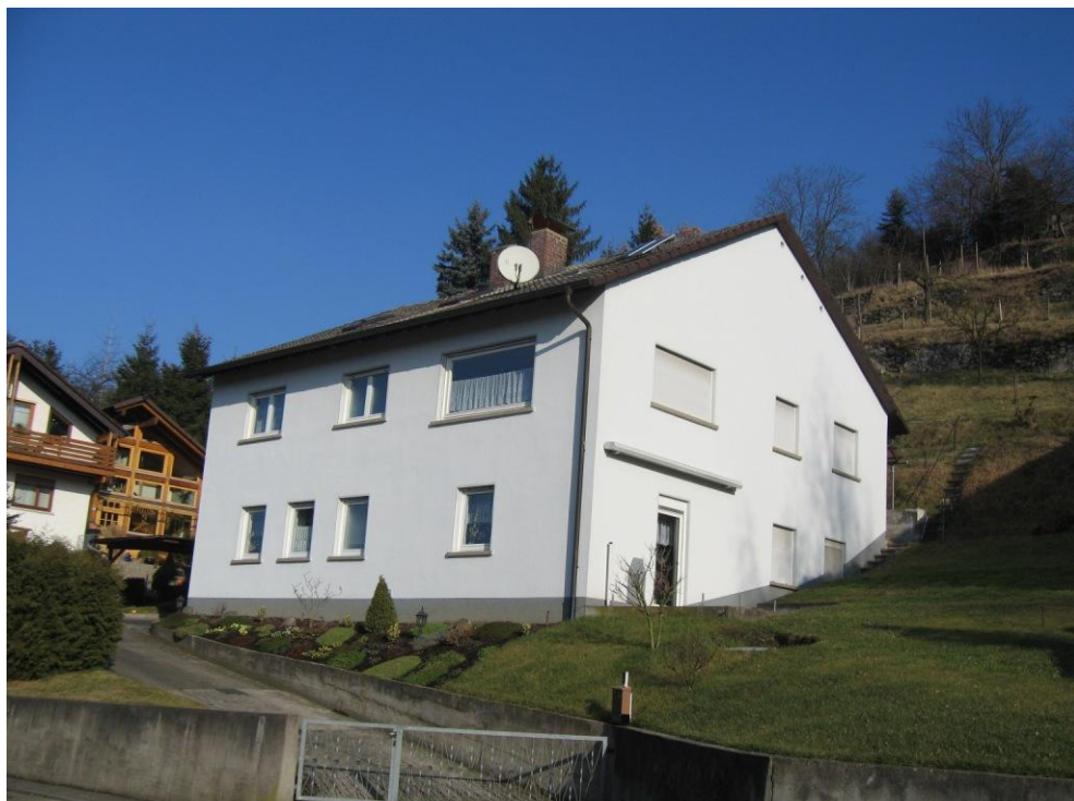
Foto 8: Gebäude „Auf der Au“ Nr. 9
