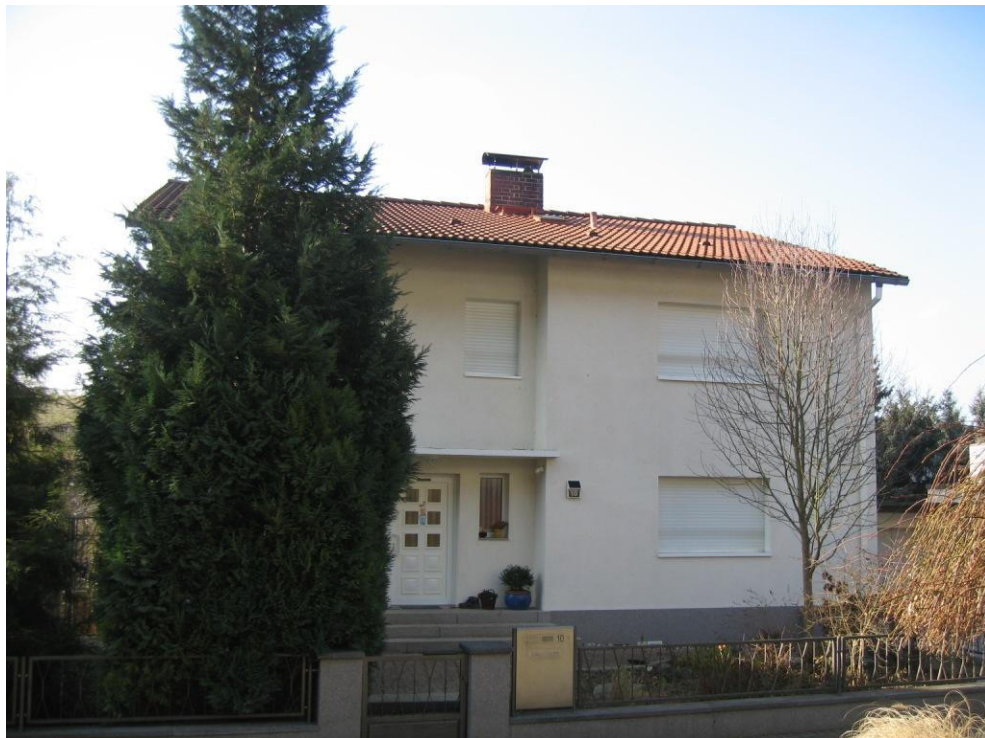
Foto 9: Gebäude „Auf der Au“ Nr. 10
