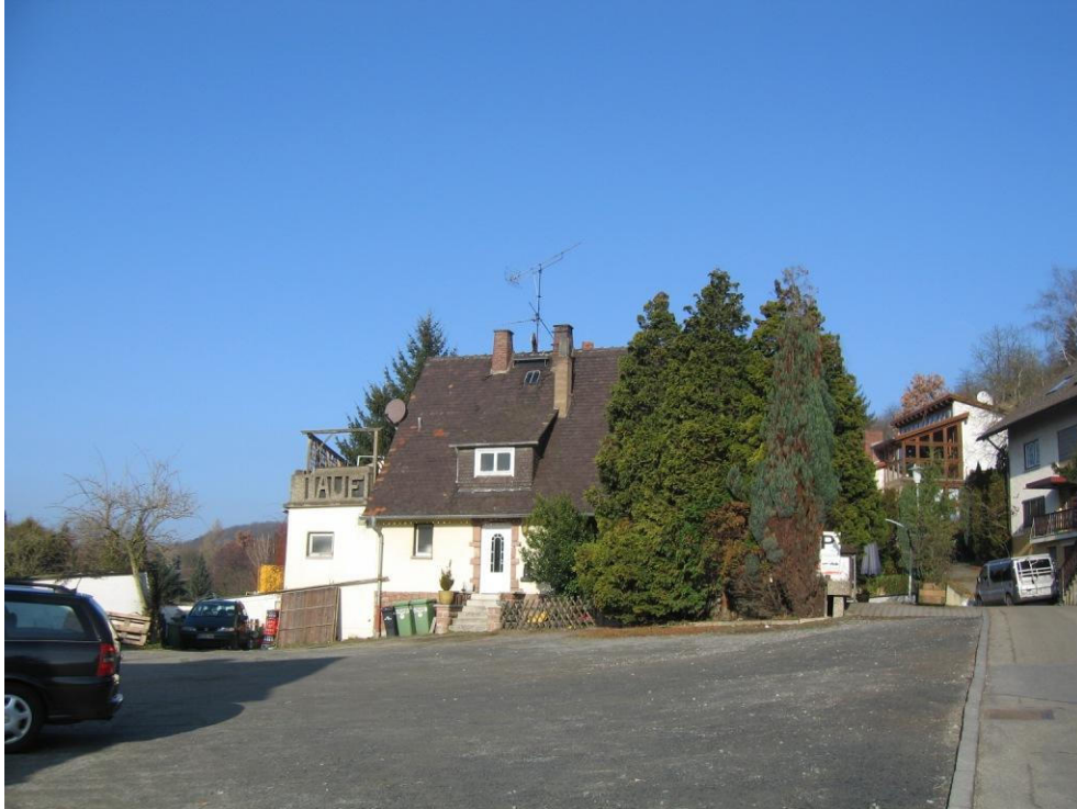
Foto 1: Gebäude „Auf der Au“ Nr. 2
