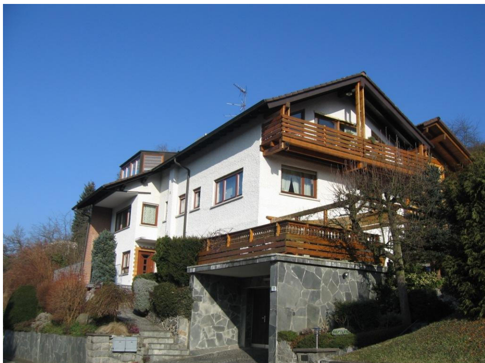
Foto 10: Gebäude „Auf der Au“ Nr. 11
