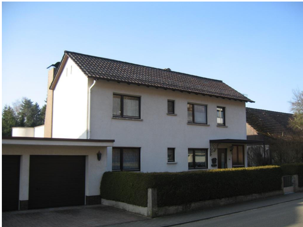
Foto 11: Gebäude „Auf der Au“ Nr. 12
