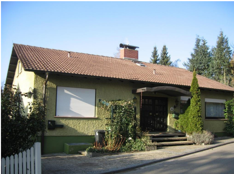
Foto 16: Gebäude „Auf der Au“ Nr. 18
