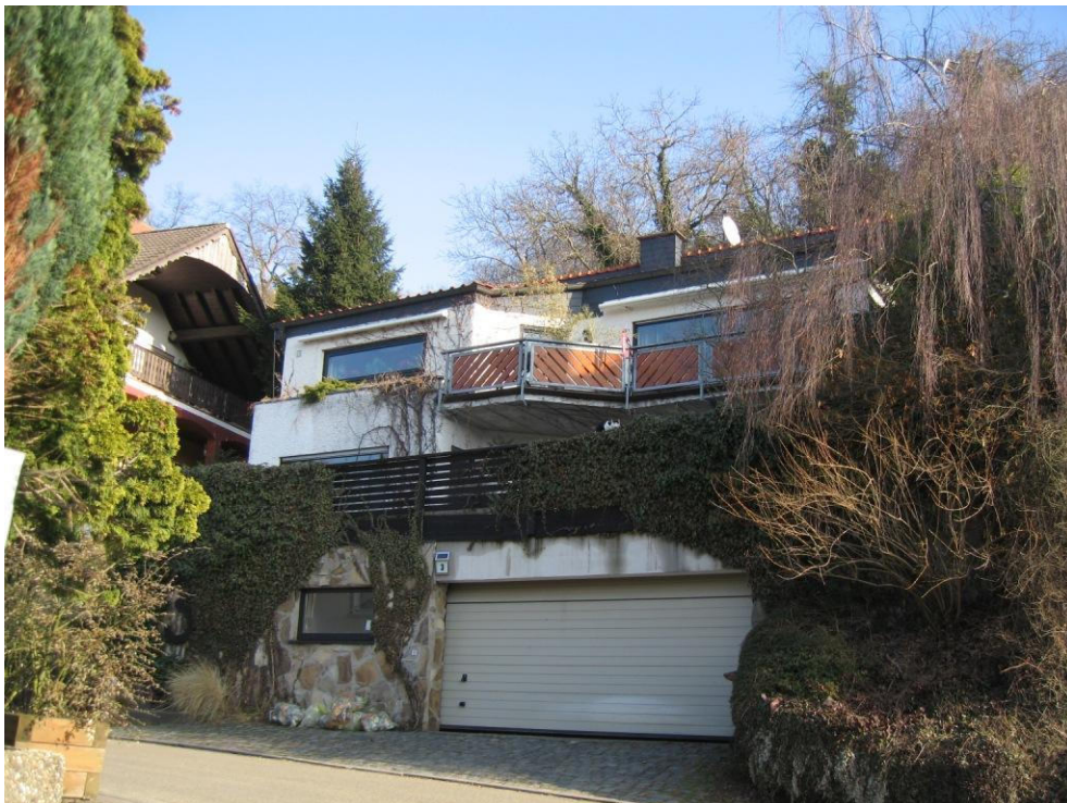
Foto 3: Gebäude „Auf der Au“ Nr. 3
