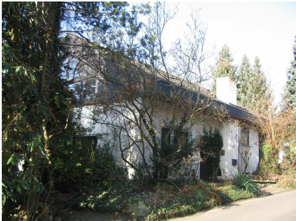
Foto 17: Gebäude „Auf der Au“ Nr. 20
