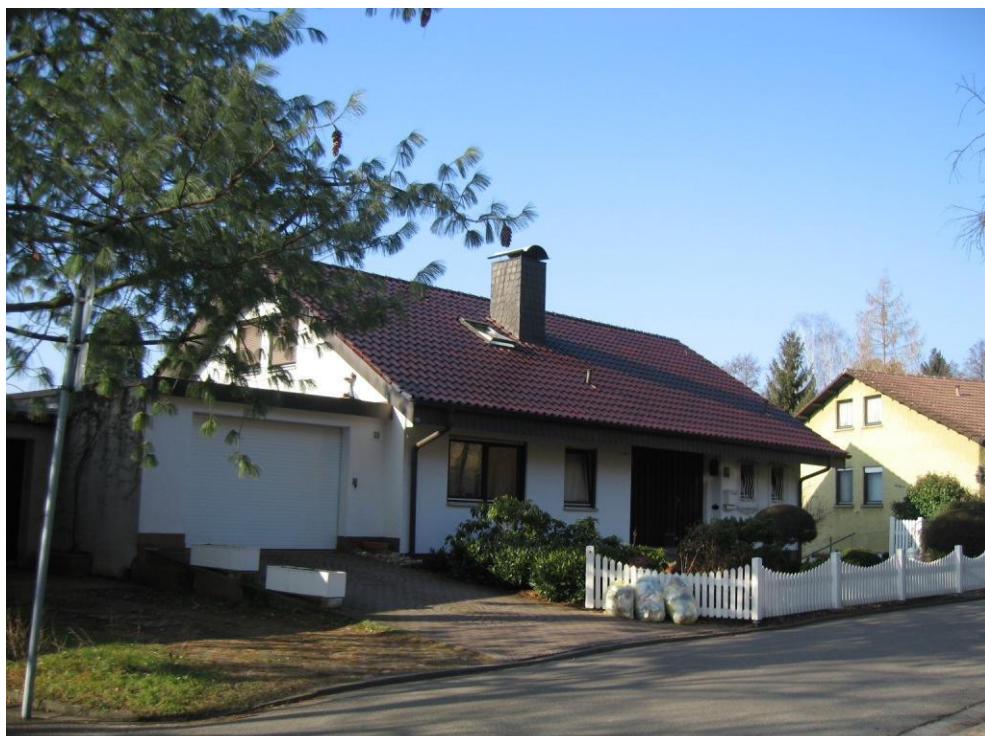
Foto 14: Gebäude „Auf der Au“ Nr. 16
