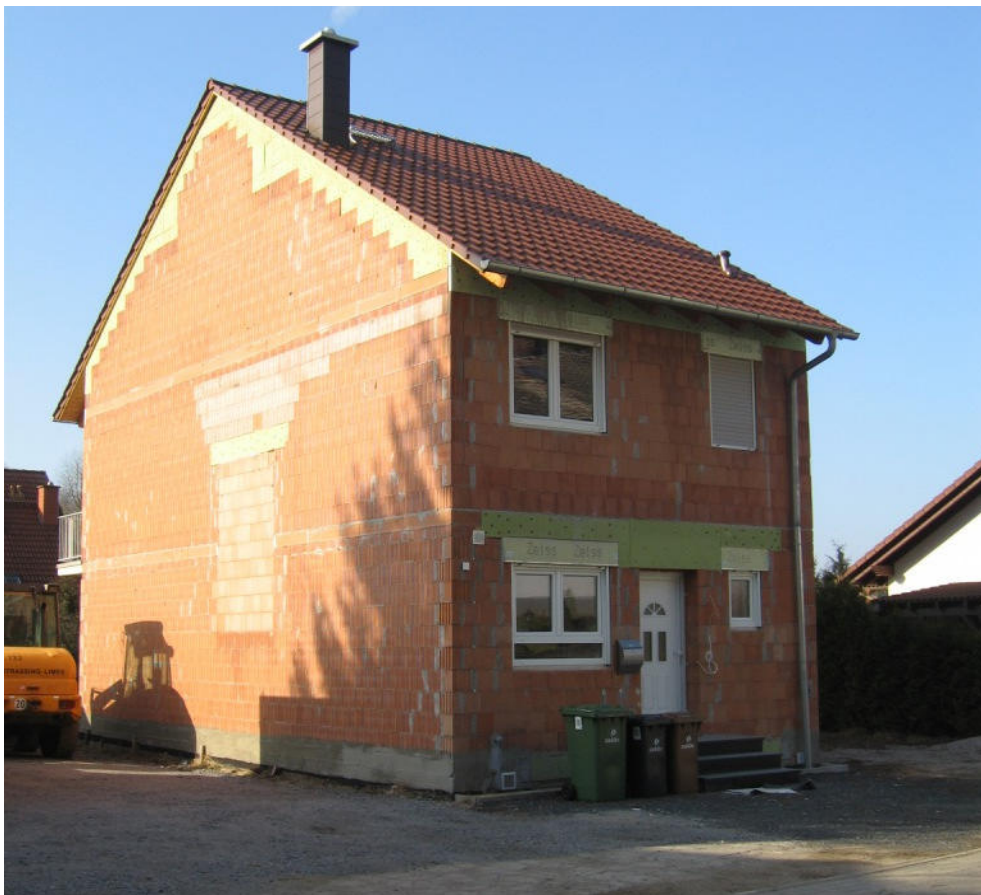
Foto 4: Gebäude „Auf der Au“ Nr. 4
