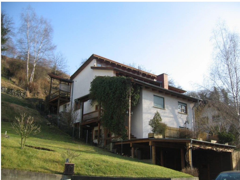
Foto 6: Gebäude „Auf der Au“ Nr. 7
