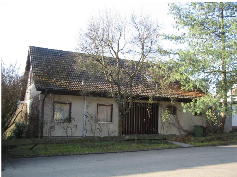
Foto 12: Gebäude „Auf der Au“ Nr. 14
