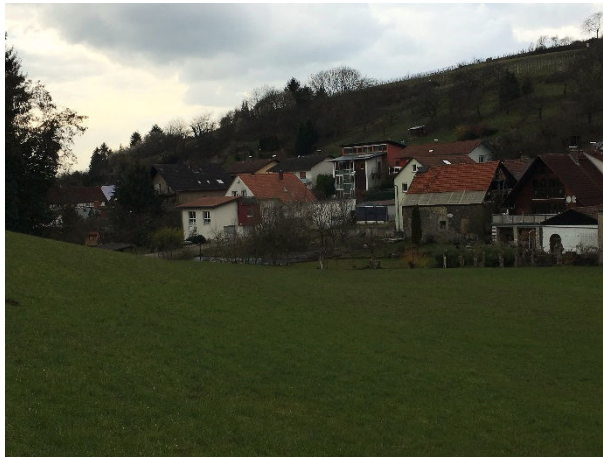
Nördlich angrenzend an den Geltungsbereich: Historisch gewachsene Siedlungsstrukturen, Aufnahme in Blickrichtung Norden
