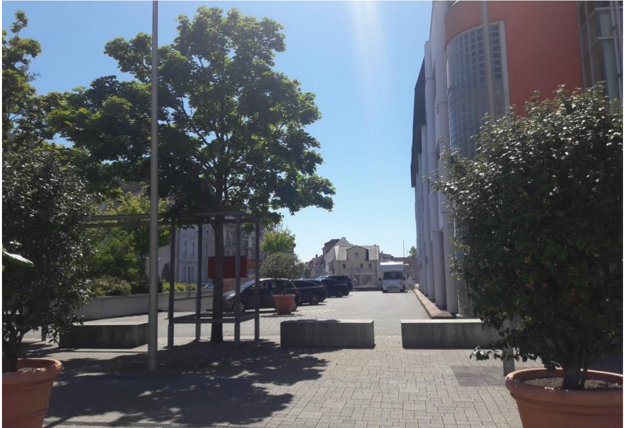
Abbildung 15: Ostfassade Sparkassengebäude (rechts) mit zugehörigen Stellplätzen (Bildquelle: SCHWEIGER + SCHOLZ Ingenieurpartnerschaft mbB, Bildaufnahme vom 31.07.2020)
