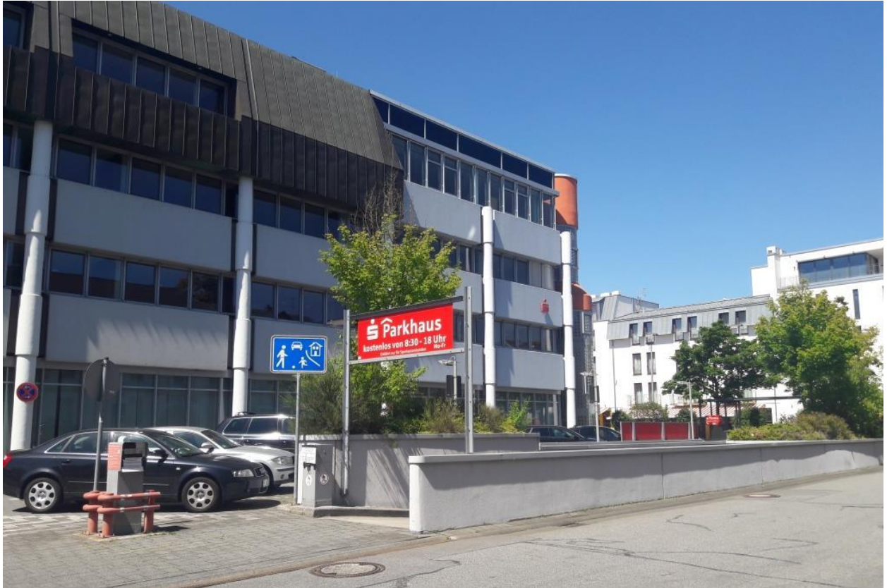
Abbildung 17: Ostfassade Sparkassengebäude mit zugehöriger Tiefgarageneinfahrt (Bildquelle: SCHWEIGER + SCHOLZ Ingenieurpartnerschaft mbB, Bildaufnahme vom 31.07.2020)
