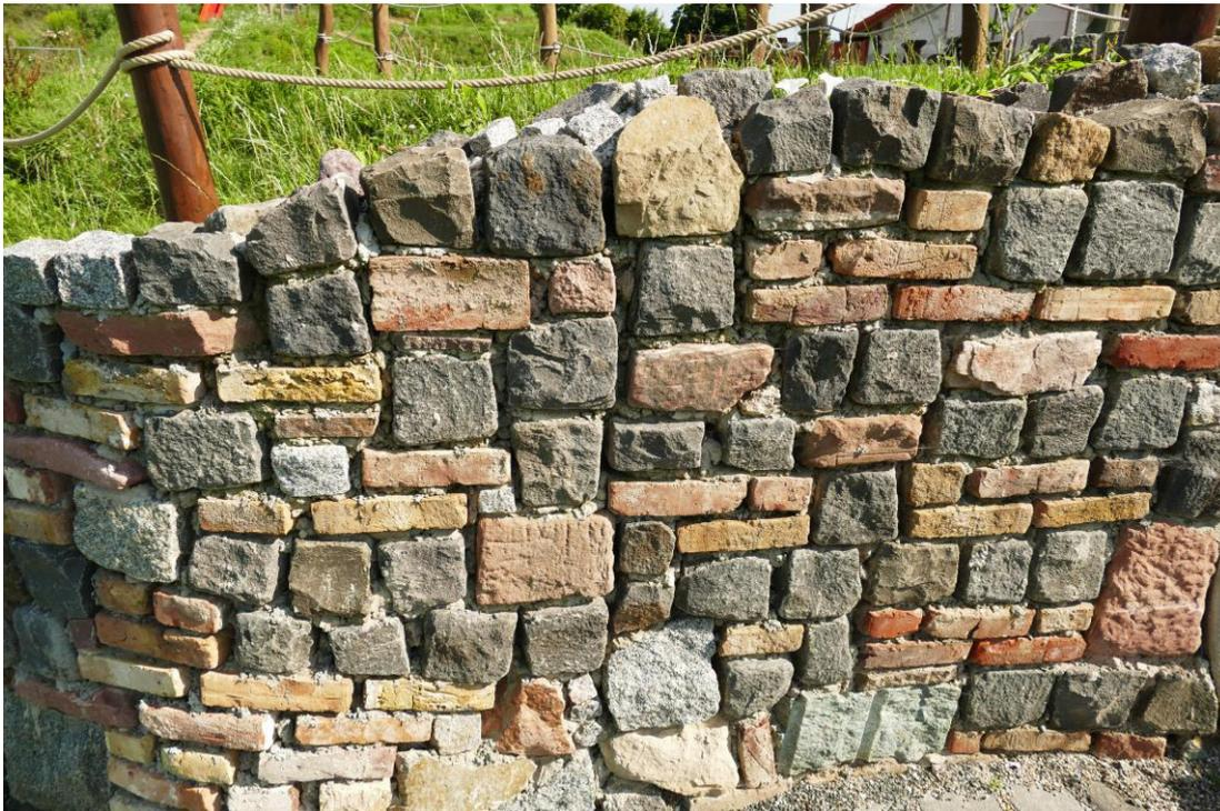
**Abb. 10:** Natursteinmauer auf dem Gelände. Hier sollten Spalten offen gelassen oder am Boden einzelne Steingut-Rohre als Tierverstecke eingebaut werden.
