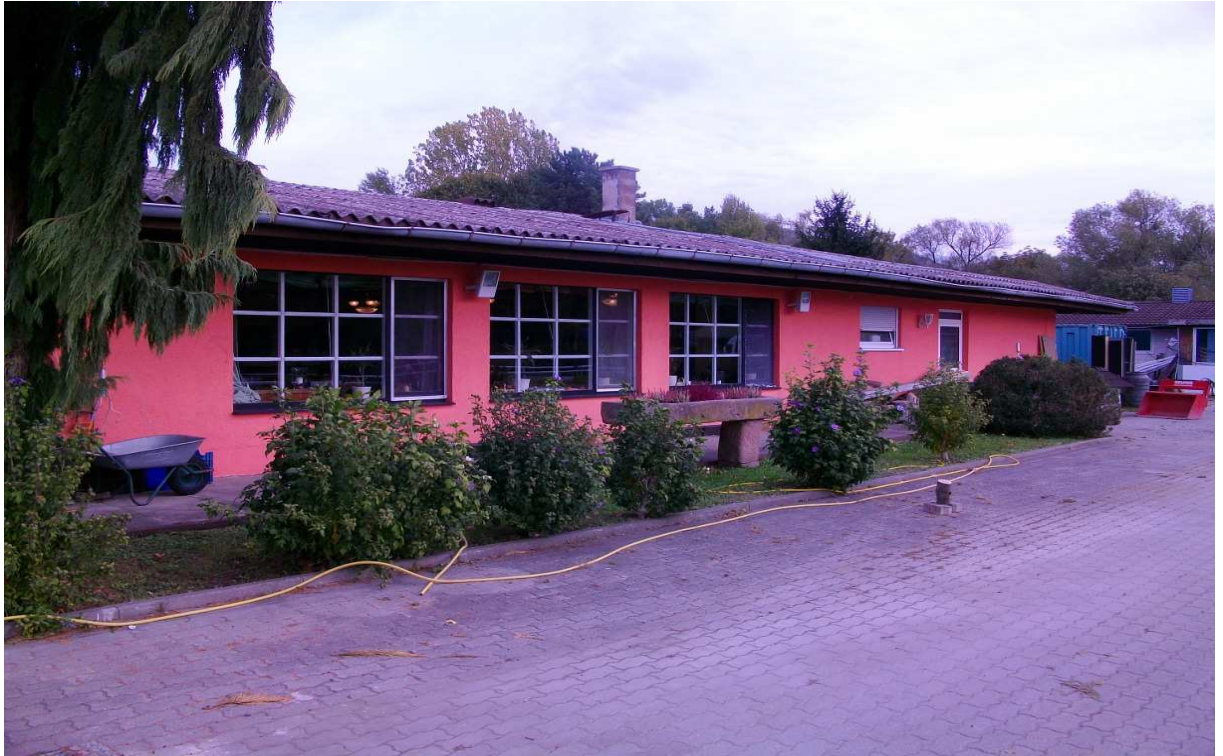
Foto 3 Situation 17.10.11. Bestandsgebäude Salotti (Restaurant), nach Ausführung der Bohrung und Ausbau zum Bodenluftpegel BL 4 unter dem Hofpflaster ( Untersuchungsabschnitt 1 , vor dem Grünstreifen).
