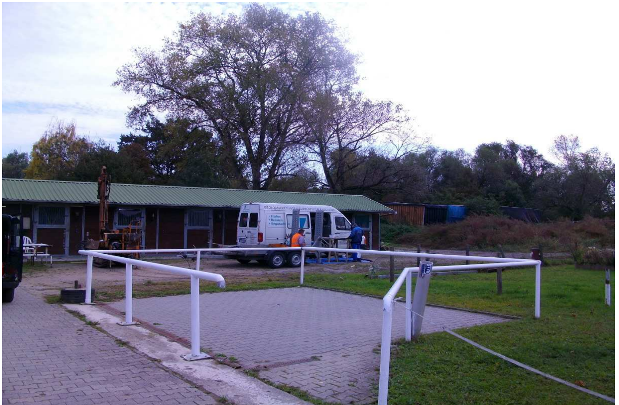
Foto 4 Situation 18.10.11. Ausführung der Bohrung und Ausbau zum Bodenluftpegel BL 6 auf der unversiegelten Freifläche vor den bestehenden Pferdestallungen ( Untersuchungsabschnitt 2 ).
