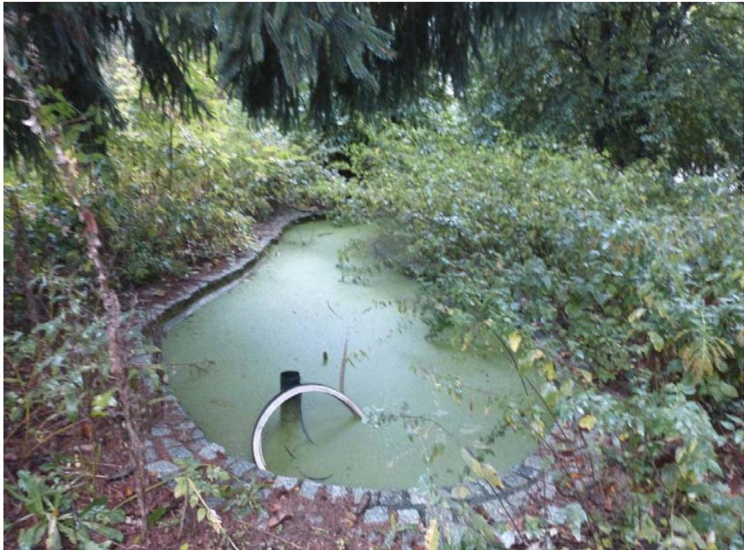
**Abbildung 5: Einer von zwei künstlichen Teichen auf dem Gelände des ehemaligen Vogelparks, die derzeit noch Wasser führen. Der Teich kann über das Rohr im Vordergrund abgelassen werden.**
