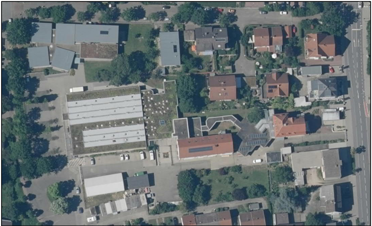
Abbildung 4: Luftbild des Geländes der Behindertenhilfe Bergstrasse (©: Hessische Verwaltung für Bodenmanagement und Geoinformation)
