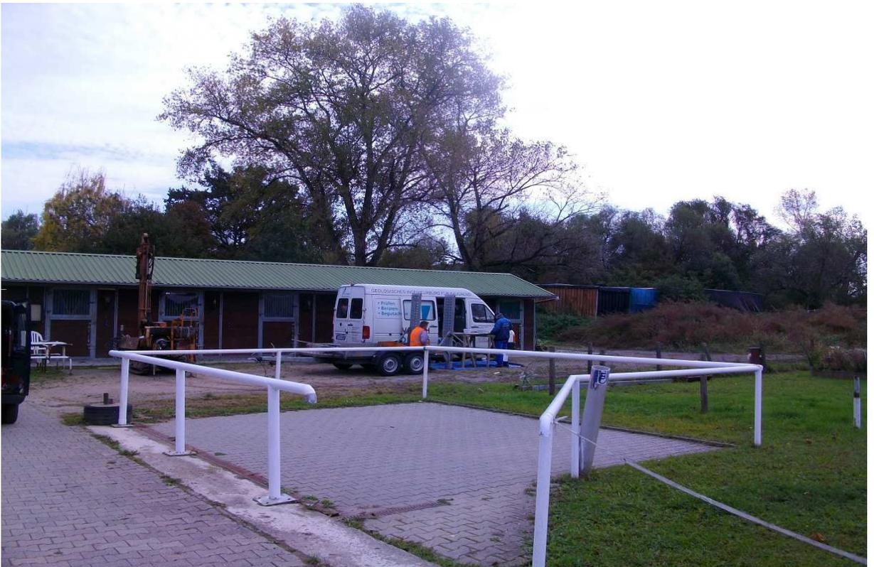
**Foto 4** Situation 18.10.11. Ausführung der Bohrung und Ausbau zum Bodenluftpegel BL 6 auf der unversiegelten Freifläche vor den bestehenden Pferdestallungen (Untersuchungsabschnitt 2).
